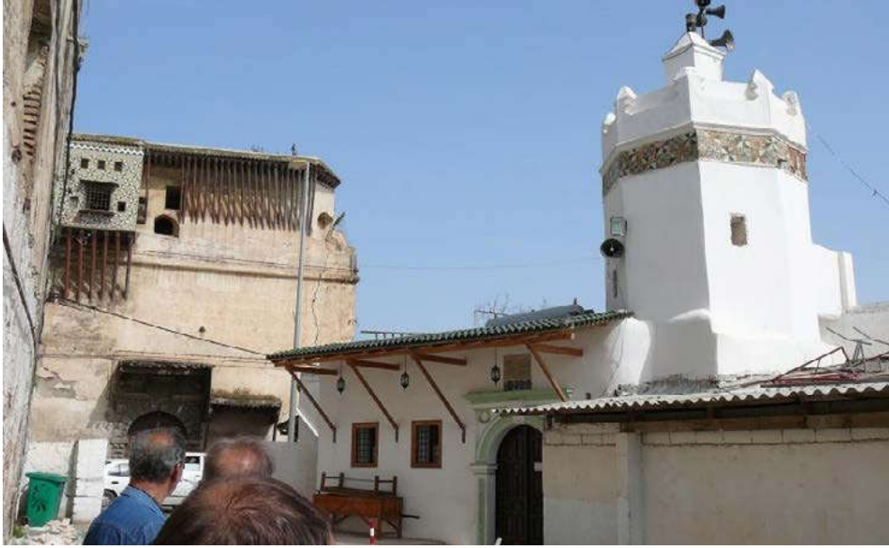
صورة رقم (٩) وتوضح واجهة مسجد «البراني» داخل قصبة «الجزائر» بعد الانتهاء من أعمال الترميم، مصدر الصورة الباحث
