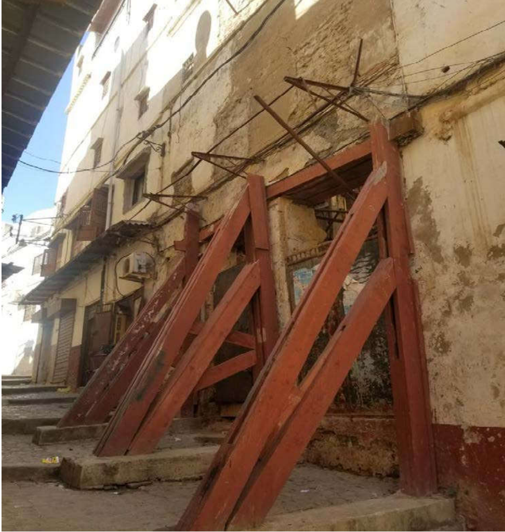
صورة رقم (٢١) وتوضح أعمال الصلب والتأمين لاحد المنازل نتيجة نقص الموارد للقيام بأعمال الترميم اللازمة للمنازل «القصبة»، مصدر الصورة: الباحث .
