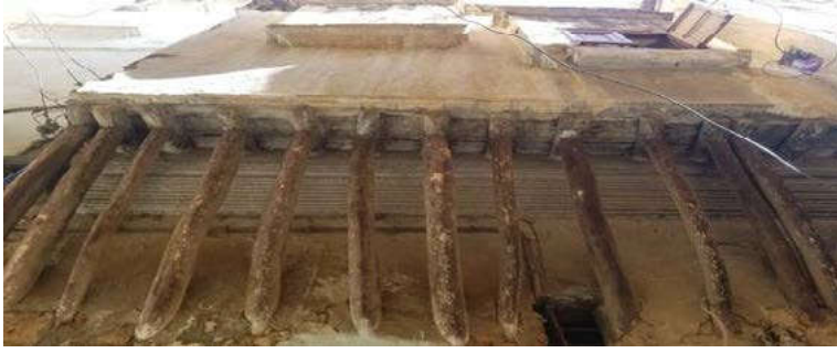
صورة رقم (١٨) وتوضح: تأثير التغيرات المناخية على واجهات المباني، والتي أدت بدورها إلى تآكل الأخشاب،
