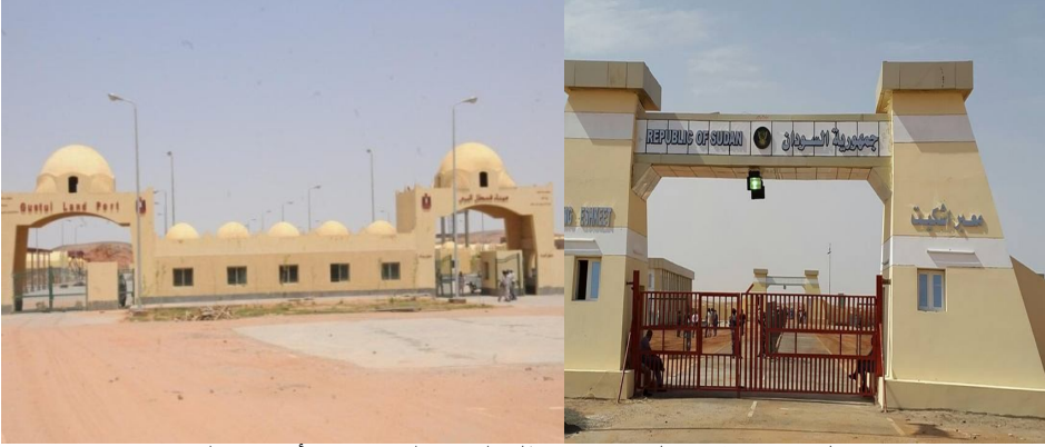
شكل : واجهة مدخل ميناء قسطل البرى المصرى وأشكيت السودانى
