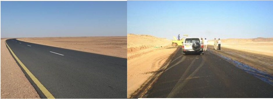
شكل : عمليات رصف طريق وادى حلف قسطل من الجهة السودانية
